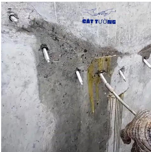
Thi công máy bơm keo PU Epoxy SL500
